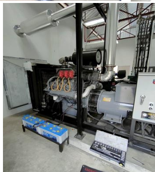
รูปการใช้ประโยชน์จากก๊าซชีวมวลในการผลิตกระแสไฟฟ้าสำหรับเครื่องกำลังผลิต 80 kWp และ 200 kWp
