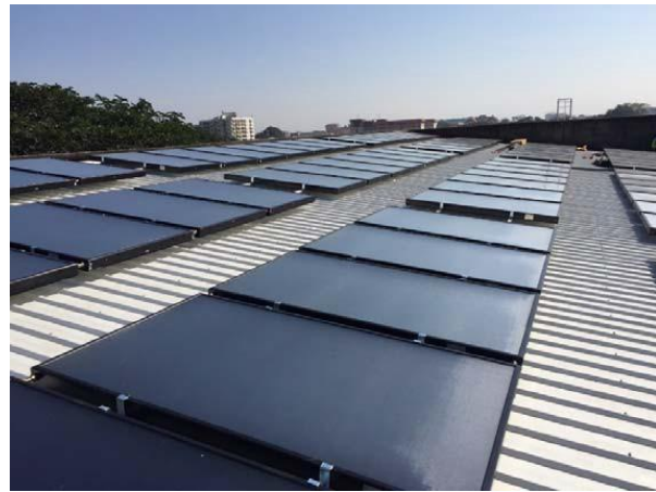
รูปการติดตั้งแผงโซลาร์น้ำร้อนบนหลังคาหอพักหญิง 4 และ 6 พื้นที่ติดตั้งรวม 406 ตร.ม.
