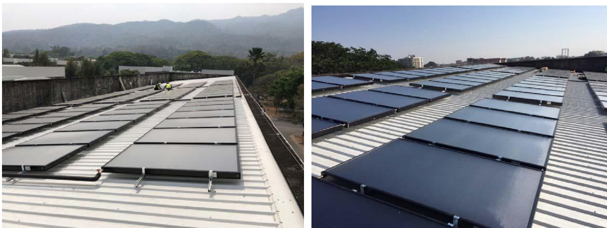
รูปการติดตั้งแผงโซลาร์น้ำร้อนบนหลังคาหอพักหญิง 4 และ 6 พื้นที่ติดตั้งรวม 406 ตร.ม.
