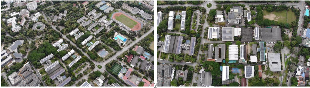
รูปมุมมองการติดตั้งโซลาร์หลังคา อาคาร 30 ปี คณะวิศวกรรมศาสตร์ และอาคารต่างๆ ของมหาวิทยาลัยเชียงใหม่
