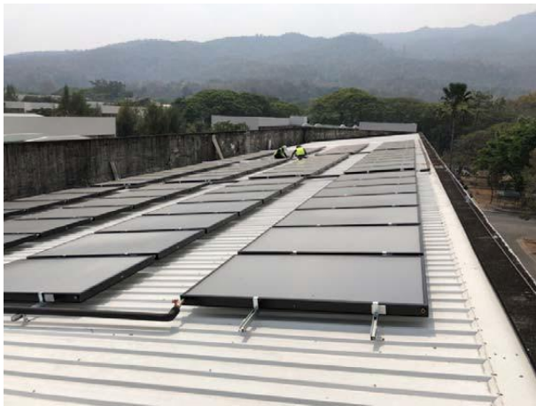
รูปการติดตั้งแผงโซลาร์น้ำร้อนบนหลังคาหอพักหญิง 4 และ 6 พื้นที่ติดตั้งรวม 406 ตร.ม.
