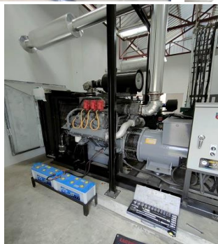
รูปการณ์ใช้ประโยชน์จากก๊าซชีวมวลในการผลิตกระแสไฟฟ้าสำหรับเครื่องกำลังผลิต 80 kWp และ 200 kWp
