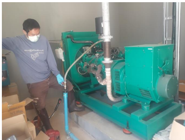
รูปการใช้ประโยชน์จากก๊าซชีวมวลในการผลิตกระแสไฟฟ้า
